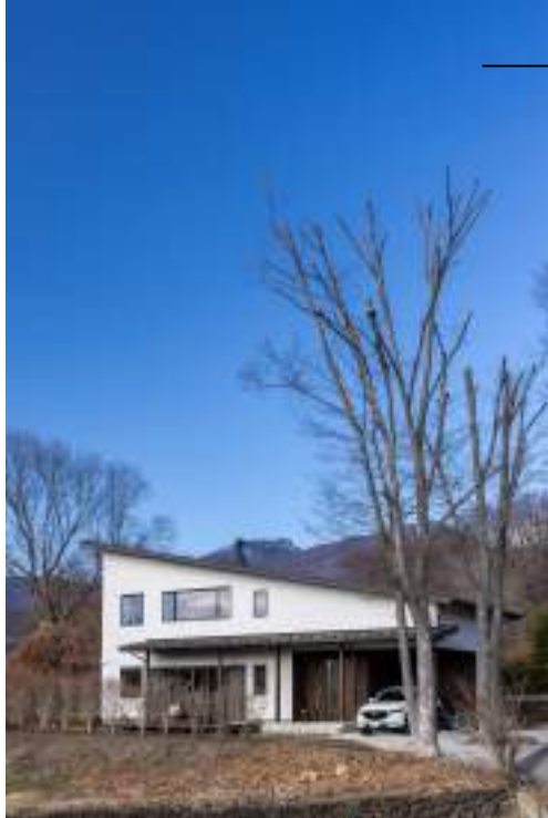
浅間山の稜線に沿うような片流れ屋根の外観。周りの木立ちに溶け込むような色使いとした。カーポートから玄関ポーチ、ウッドデッキにかかる下屋がアクセントに。
